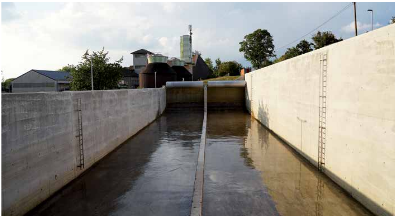
Das Regenrückhaltebecken ist 46 Meter lang, 14 Meter breit und fasst rund 2.200 Kubikmeter. (Bild: Stadtverwaltung Hockenheim)
