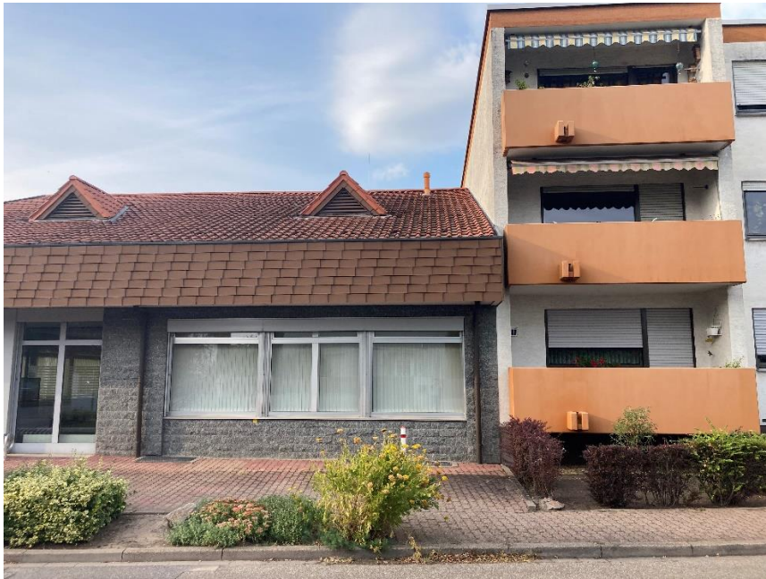
bestehende Grenzbebauung, vorhandene Diskrepanz durch verschiedene Gebäudekubaturen und Dachformen
