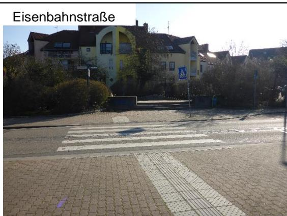
Vollständig barrierefrei ausgebaute Querungshilfe
