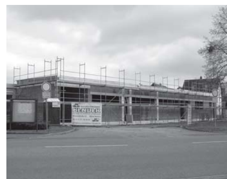
Fehlende Räumlichkeiten gehören bei der Freiwilligen Feuerwehr bald der Vergangenheit an. Foto: FFW
