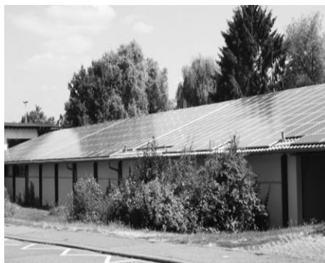
Die Bürgersolaranlage auf dem Dach des Aquadroms.
