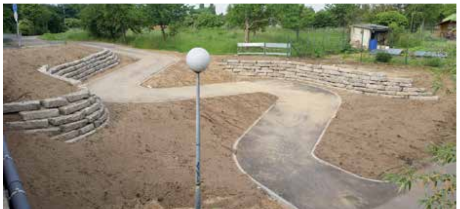
Die neue Verbindung am Südring macht den Übergang in Richtung Aquadrom noch leichter.
