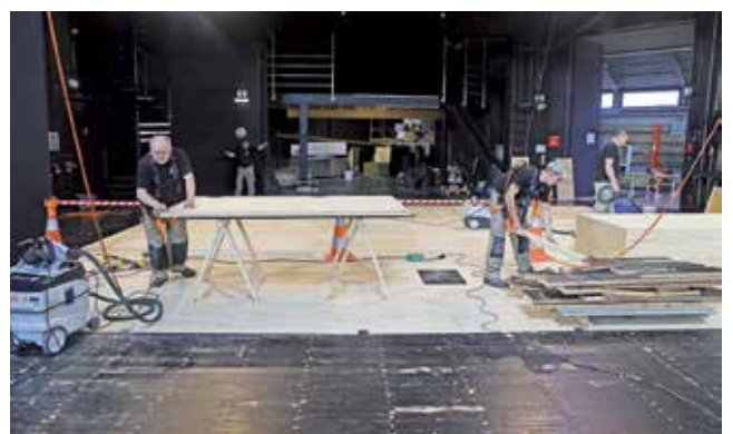
Bauarbeiter tauschen den Hallenboden aus.
