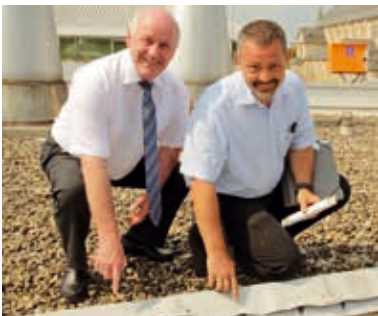
Auf dem Dach der Stadthalle
