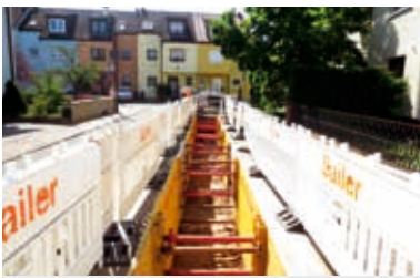
Sanierung schreitet voran
