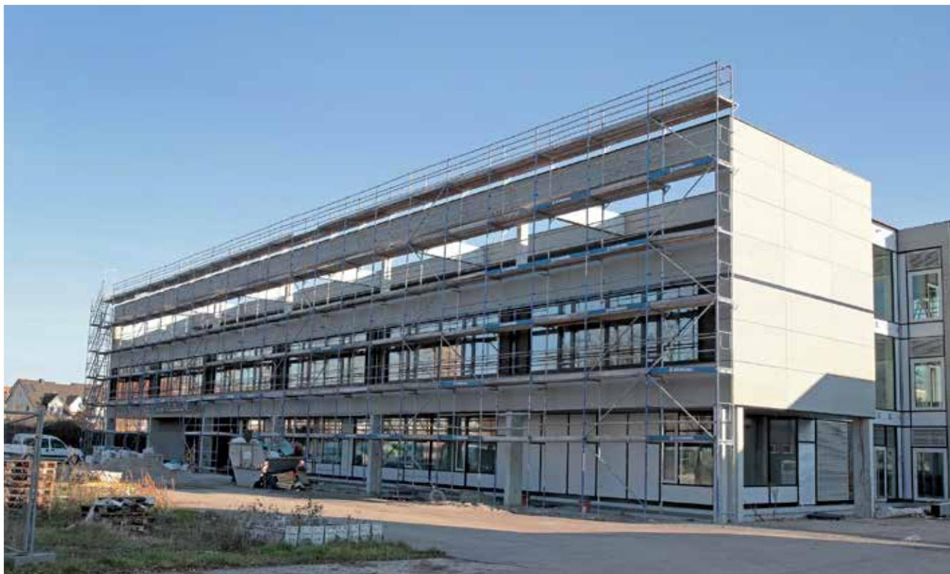
Auch die Arbeiten an der „Grundschule plus“ (Hartmann-Baumann-Schule) liefen 2021 Hochtouren. Die Fassaden- und Fensterarbeiten konnten weitestgehend beendet werden. Die Metalltüren sind teilweise eingebaut. Außerdem sind alle großen Gewerke des Innenausbaus, die WC-Trennwände und die mobile Trennwand ausgeschrieben und bestellt. Mit der Fertigstellung ist im Frühjahr 2022 zu rechnen.
