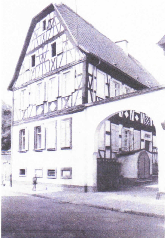
Das Gasthaus »Zum Güldenen Engel« vor dem Umbau zum heutigen Restaurant.
