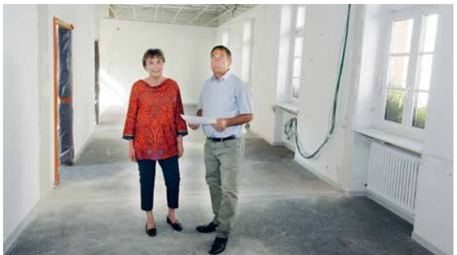
Die Werkleitung Martina Schleicher (l.) und Erhard Metzler begutachten das Erdgeschoss.
