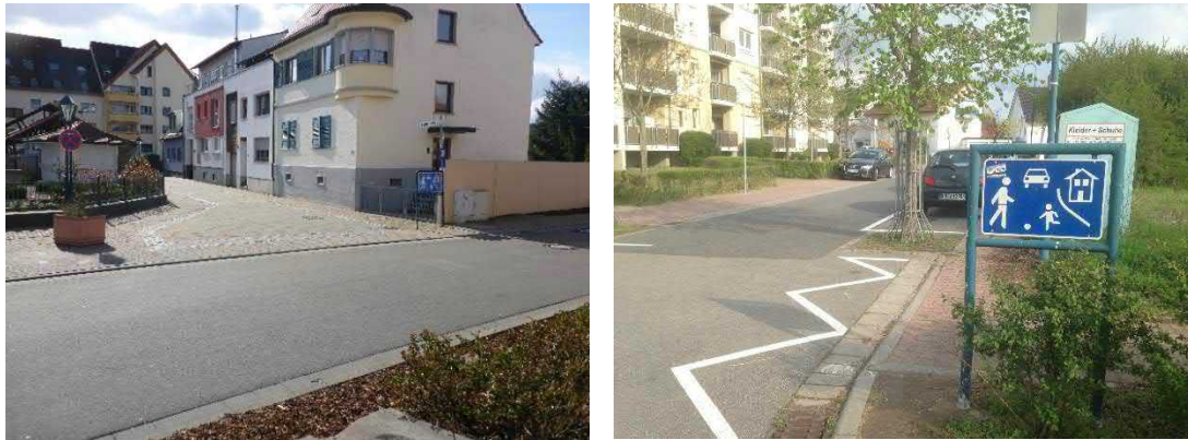
Abbildung 67: Einmündung Untere Mühlstraße als verkehrsberuhigter Bereich (links) und in der Albert-Einstein-Straße am Hubäckerring (rechts)
