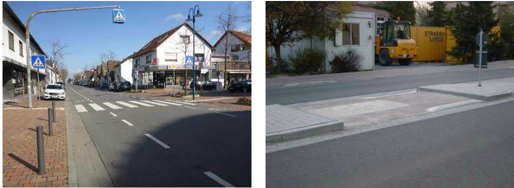
Abbildung 65: Beispiele zu barrierefreien Angeboten im öffentlichen Straßenraum (Querungsstelle über die Schwetzinger Straße (links) / Beispiel für barrierefreie Mittelinsel (rechts))
